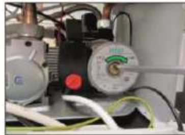
2. Отвинтите центральный винт с помощью отвертки
