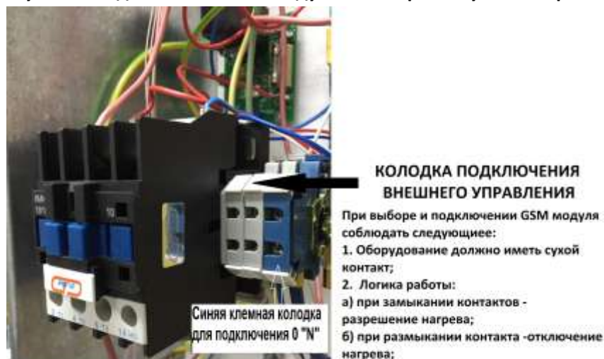
Рисунок 9. Подключение GSM модуля к электродкотлу РЭКО серии ПМ
