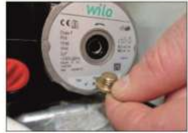
3. Дайте оставшейся воде вытечь, подставив при этом под нее соответствующую емкость
