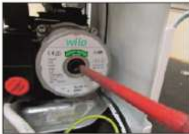
1. Откройте лицевую панель для доступа к насосу
