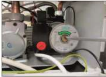
2. Отвинтите центральный винт с помощью отвертки
